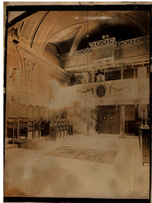
Interiorul bisericii grecești, vedere spre apus. Fotografie realizată în ajunul demarării lucrărilor de demolare.
