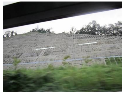
Consolidarea unui deal, pentru protejarea șoselei
