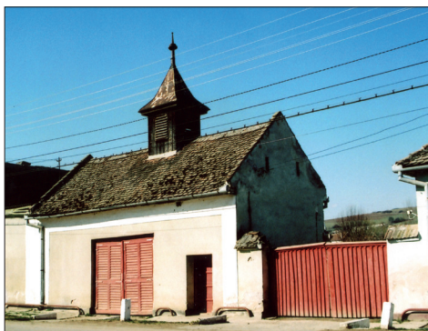
Fig. 523. Vurpăr (jud. Sibiu). Remiza construită de Asociația Pompierilor Voluntari după anul 1887 (Foto: 2014)
