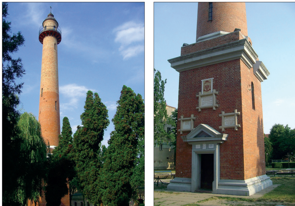
Fig. 499 a - b. Satu Mare (jud. Satu Mare). Turnul Pompierilor cu înălțimea de 47 m, construit între anii 1903-1904 (Foto: 2013)
