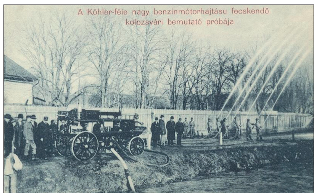
Fig. 426. Cluj-Napoca (jud. Cluj). Exercițiu pe malul Someșului Mic pentru verificarea eficienței unei pompe cu motor pe benzină tip „Köhler” (Fotografie din jurul anului 1910)
