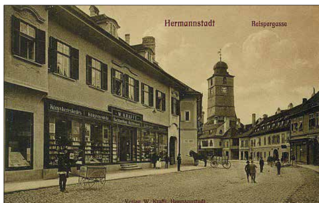
Foto 110. Înainte de anul 1893 librăria și tipografia Krafft dețineau utilaje acționate electric
