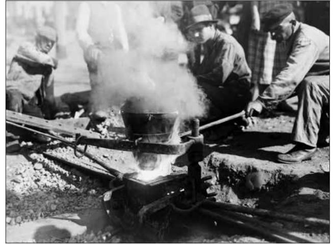
Foto 336. Îmbunătățirea calității transportului cu tramvaie în Sibiu, prin sudarea cap la cap a șinelor (1923)
