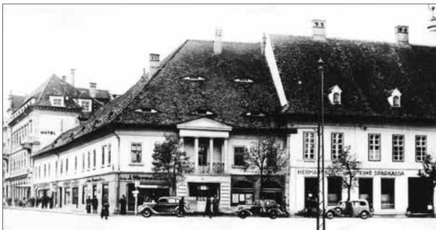
Foto 96. Sediul celei mai importante bănci săsești, Hermannstädter Allgemeine Sparkassa, aflat în Piața Mare din Sibiu. Banca a fost un important instrument pentru lupta împotriva crizei (~1930)
