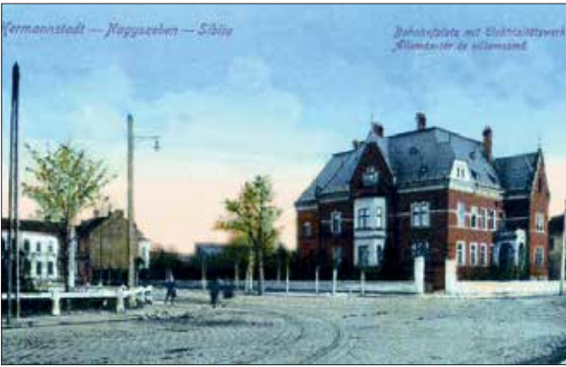
Foto 596. În pofida valorii istorice și arhitectonice, vechiul sediu HEW - datând din anul 1902 - a fost demolat (1987)
