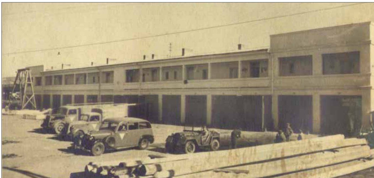
Foto 473. Pentru creșterea operativității intervențiilor noile garaje ale întreprinderii erau prevăzute - la etaj - cu locuințe de serviciu (1951)
