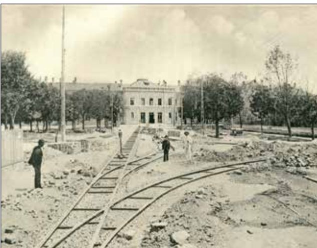
Foto 243. Construirea liniei de tramvai – Piața Gării (1905)
