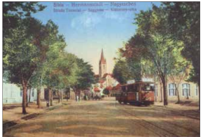
Foto 284. Tramvai în str. Turnului (~1930)
