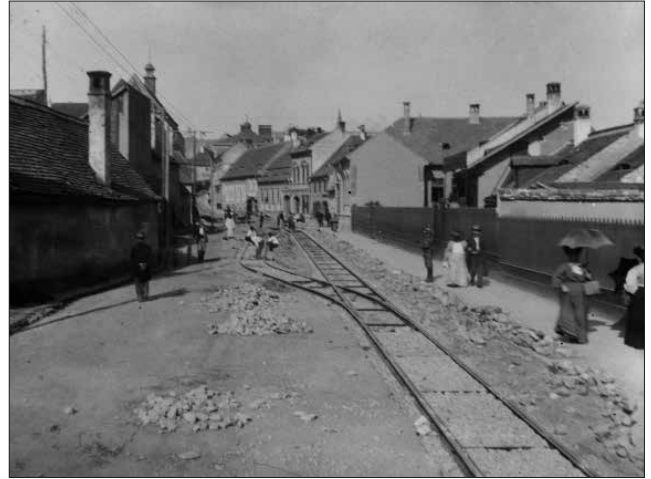
Foto 242. Construirea liniei de tramvai – str. Magheru (1905)
