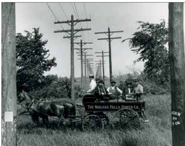
Foto 24. Linia Niagara - Buffalo a impulsionat tehnologia transportului la distanță al electricității (foto 1902)
