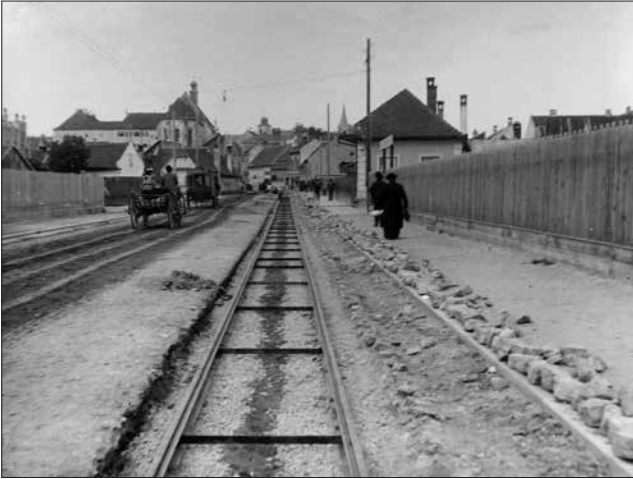
Foto 241. Construirea liniei de tramvai – str. Magheru (1905)
