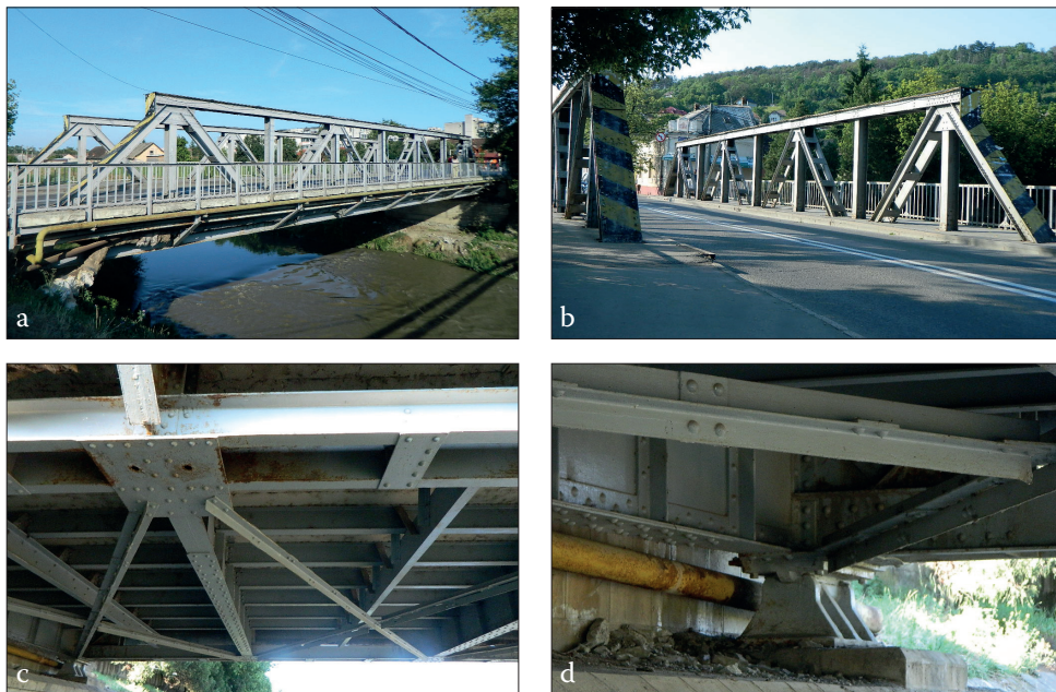
Fig. 320 a – d. Târnăveni (jud. Mureș). Podul de fier peste râul Târnavă Mică, construit în anul 1931 la fabrica de vagoane „Astra” din Arad, a) Elevația amonte; b) Carosabilul podului; c) Structura de rezistență (eșafodajul); d. Detaliu cu elemente de articulație
