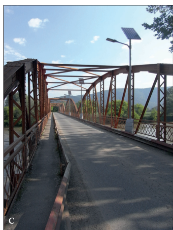
Fig. 319 a – c. Săvârșin (jud. Arad). Podul de metal cu patru deschideri peste râul Mureș, a) Carte poștală ilustrată din jurul anului 1910; b – c) Aspectul podului reconșionat și iluminat electric (Foto: 2014)
