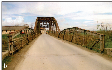
Fig. 318 a – b. Podul Olt (jud. Covasna). Podul de fier cu două deschideri peste râul Olt; a) Elevația amonte b) Carosabilul (Foto: 2014)
