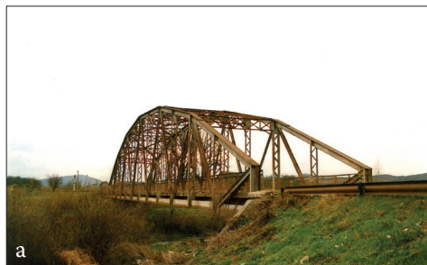
Fig. 318 a – b. Podul Olt (jud. Covasna). Podul de fier cu două deschideri peste râul Olt; a) Elevația amonte b) Carosabilul (Foto: 2014)
