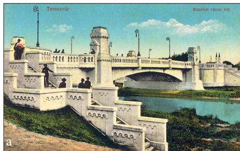
Fig. 304 a – c. Timișoara (jud. Timiș). Podul Mitropolit Andrei Șaguna denumit și „Podul Episcopal” construit din beton armat cu structură în arc în anul 1914, a) Carte poștă ilustrată din jurul anului 1916, b) (Foto: Árpád Jancsó, 2010)
