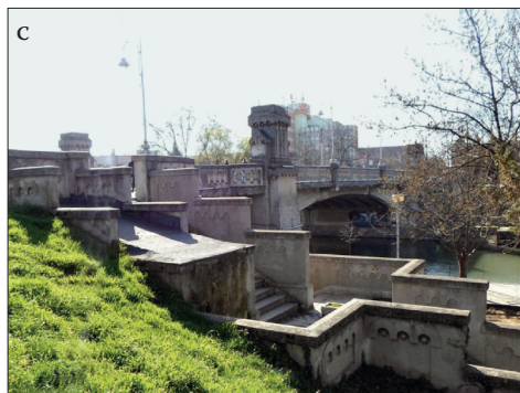
Fig. 304 a – c. Timișoara (jud. Timiș). Podul Mitropolit Andrei Șaguna denumit și „Podul Episcopal” construit din beton armat cu structură în arc în anul 1914, a) Carte poștă ilustrată din jurul anului 1916, b) (Foto: Árpád Jancsó, 2010)
