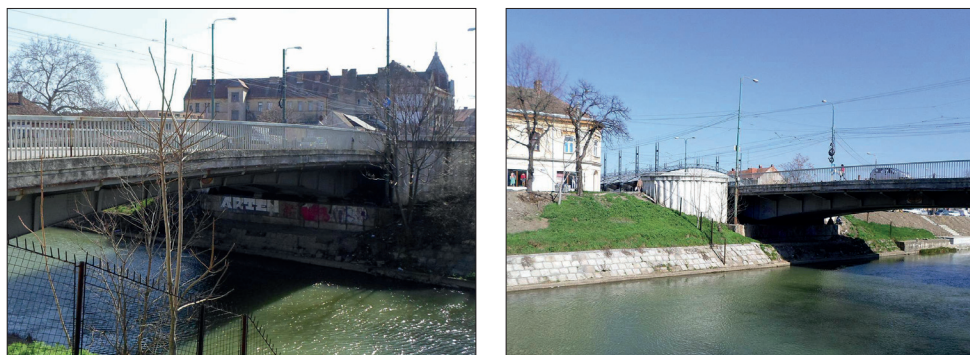
Fig. 303 a – b. Timișoara (jud. Timiș). Podul Dacilor denumit și „Podul din Piața de Fân” construit din beton armat în anul 1908 (Foto: Constantin Liciu, 2014)
