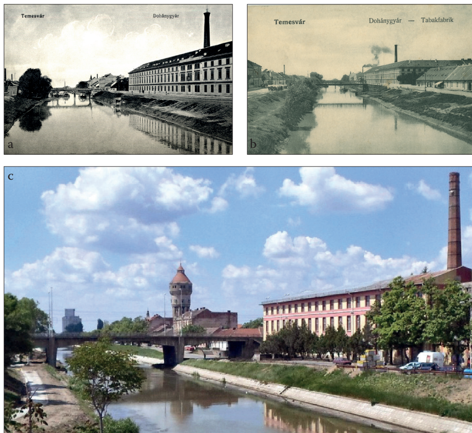
Fig. 298 a - c. Timișoara (jud. Timiș). Podul Muncii , a) Vechiul pod de la Fabrica de tutun construit din lemn (Carte poștală ilustrată din jurul anului 1910); b) Noul pod cu suprastructură metalică construit în 1913 (Carte poștală din jurul anului 1915); c) Noul pod din beton armat construit în anul 1977 (Foto: Constantin Liciu, 2014)
