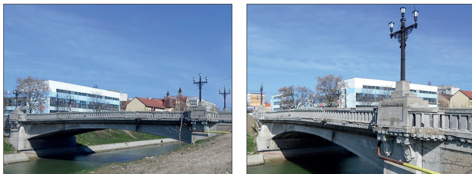
Fig. 296 a – b. Timișoara (jud. Timiș). Podul „Eroilor”, Podul de beton armat construit în locul podului „Bem” în anul 1939 (Foto. Constantin Liciu, 2014)
