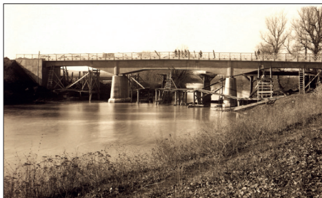
Fig. 292. Sebiș (jud. Arad). Podul rutier construit din beton armat între Sebiș și Buteni în faza de finalizare (Fotografie din jurul anului 1930)
