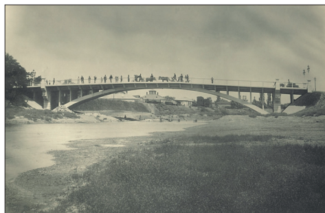
Fig. 290 a – b. Tecuci (jud. Galați). Podul de beton armat de 50 m deschidere peste râul Bârlad inaugurat în anul 1912 (după Album General p. 20, 22)
