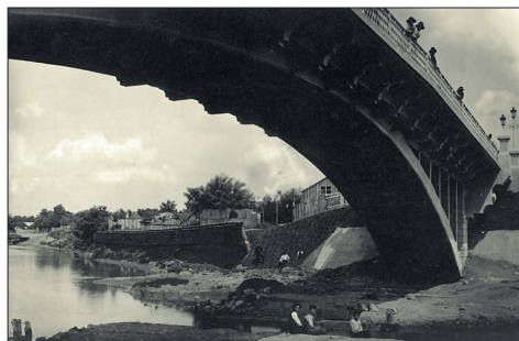
Fig. 290 a – b. Tecuci (jud. Galați). Podul de beton armat de 50 m deschidere peste râul Bârlad inaugurat în anul 1912 (după Album General p. 20, 22)
