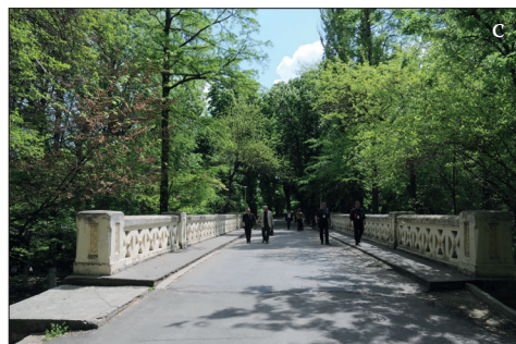
Fig. 295 a - d. București. Podul Gogu Constantinescu din Parcul Carol primul pod de beton cu arc cu travee drepte, a - b) Elevația podului; c) Carosabilul; d) Inscricția cu anul construcției (Foto: Lucian Muntean, 2014)
