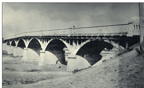
Fig. 282. Văleni (jud. Olt). Podul de beton armat de 116 m lungime peste râul Vedea (după Album General , p. 37)
