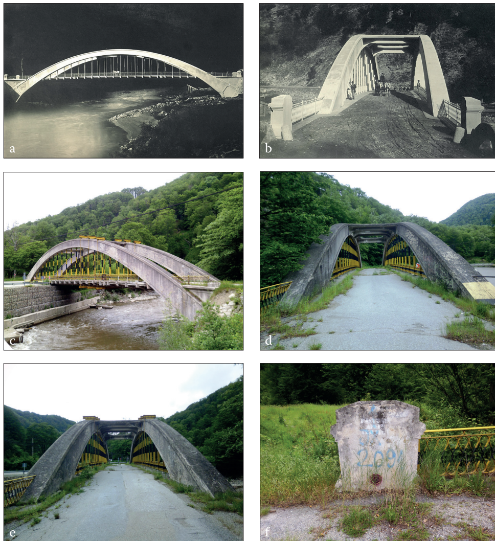
Fig. 281 a – f. Defileul Jiului. a - b) Podul de beton armat de 60 m deschidere peste râul Jiul lângă „Vama” Lainici (după Album General , p 61-62); c - f) Starea actuală de conservare după dezafectarea podului (Foto: 2014)
