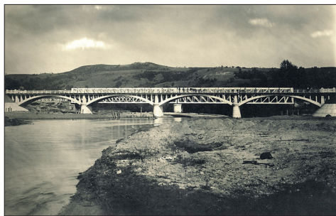
Fig. 285. Butoiești (jud. Mehedinți). Podul de beton armat de 115 m lungime peste râul Motru (după Album General , p. 30)
