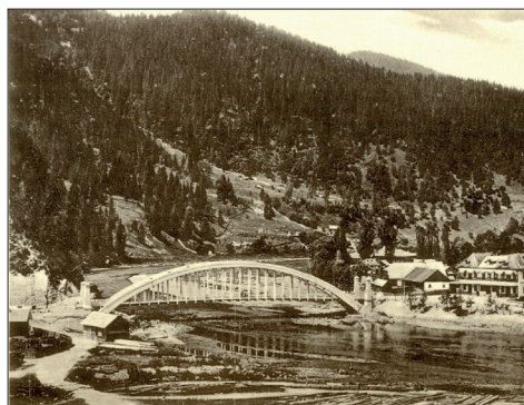
Fig. 277. Broșteni (jud. Neamț). Podul de beton cu o deschidere de 78 m peste râul Bistrița (Carte poștală ilustrată din jurul anului 1910)
