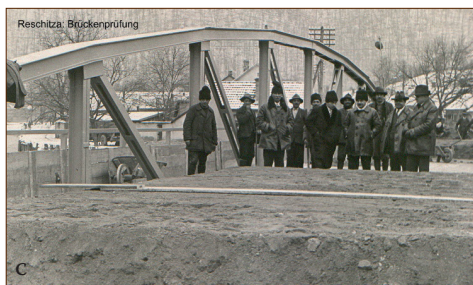
Fig. 251 a - c. Reșița (jud. Caraș-Severin). Construcția podului sudat din Stavila în anul 1931, a - b) Montarea traverselor scheletului metalic; c) Proba la sarcini a podului realizată printr-un strat de pietriș afânat (Fotoilustrată din anul 1931)
