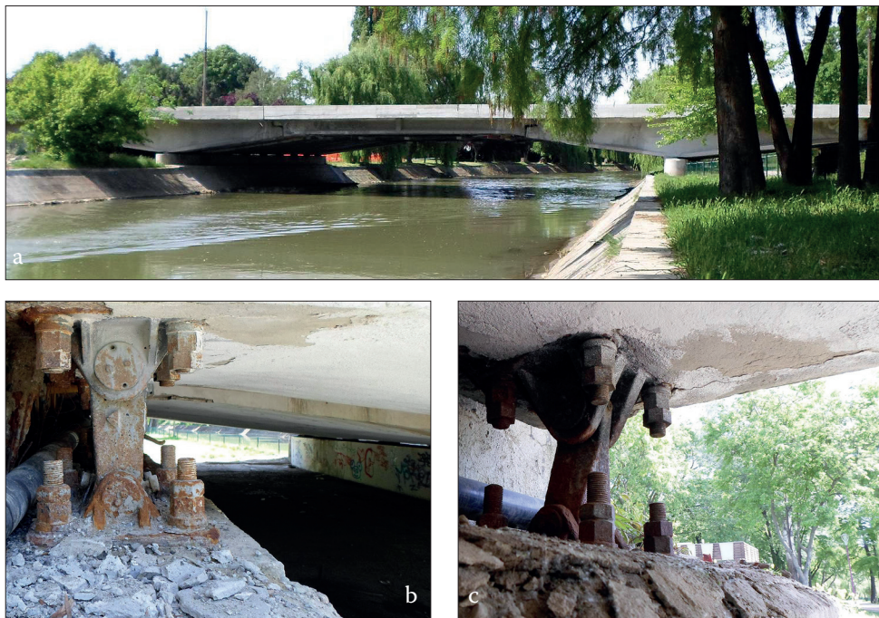
Fig. 239 a - c. Timișoara (jud. Timiș). Podul „Michelangelo” construit în locul vechiului pod de lemn de pietoni cunoscut sub numele „Pasarela Studenților” ; a) Vedere generală; b - c) Detalii cu elementele de articulații (Foto: C. Liciu, 2013)
