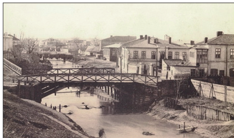
Fig. 225. București. Podul de lemn peste Dâmbovița „Radu Vodă” (Fotografie din anul 1874 realizată de F. Duschek)
