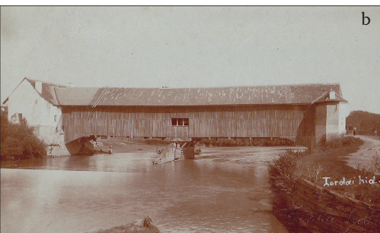
Fig. 203 a – c. Turda (jud. Cluj). Podul de lemn acoperit peste râul Arieș construit de János Kövecsi, a - b) A doua fază a construcției podului sprijinit pe un singur pilon (Cărți poștale ilustrate din jurul anul 1900); c) Podul de lemn sprijinit pe trei piloni (Carte poștale ilustrată din jurul anului 1905)
