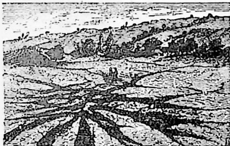
Fig. 49. Crăpături produse în pământ în urma cutremurului din Calabria dela 1783.
