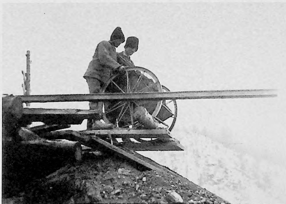
89. Valea Voicului - Pila 8. Extragerea pământului săpat în fundație cu cupa basculante ridicate cu liftul/ 2 decembrie 1948
