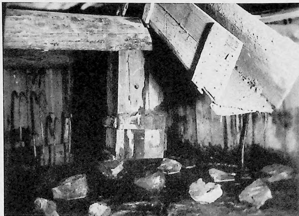
94. Valea Voicului - Pila 8. Betonarea fundației. Așezarea pietrei brute/ 9 decembrie 1948
