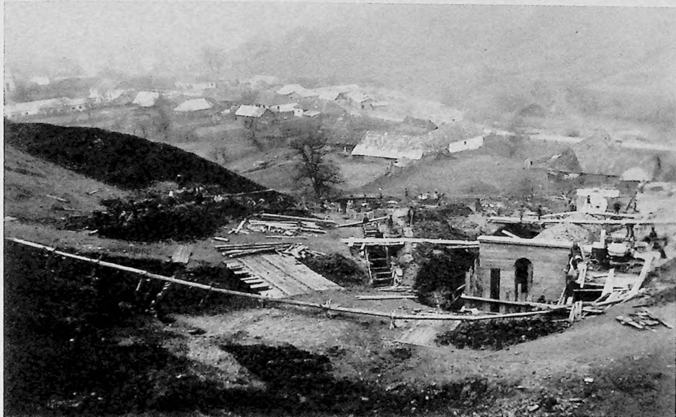
36. Podet - Km 31+625. Săpături în drenuri spre Salva/ 1 noiembrie 1948
