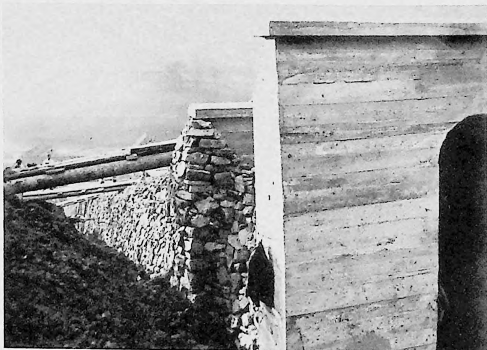
24. Podet - Km 31+625. Vedere amonte - Drenul / 28 octombrie 1948
