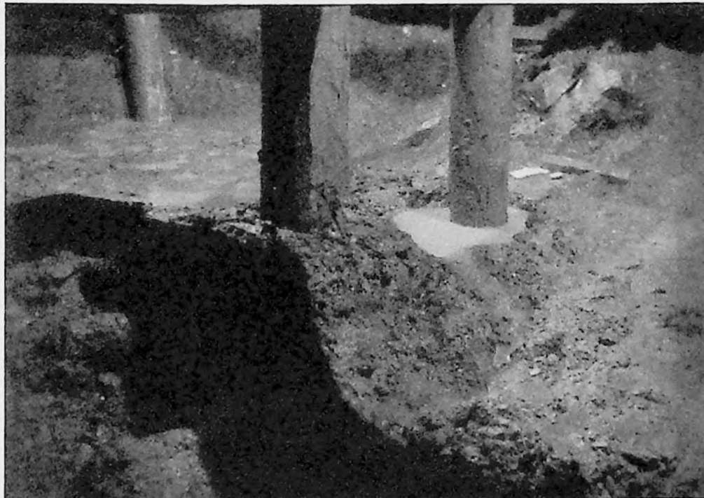
7. Valea Voicului - Pila 5. Săpătura de fundație la pila 5/ 24 septembrie 1948
