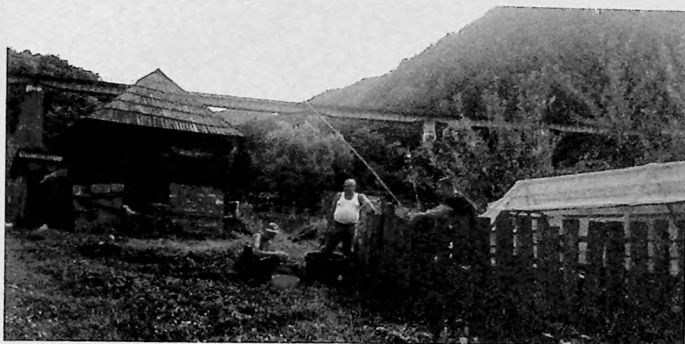
Viaductul de la Romuli/ Romuli Viaduct. 2018. Foto/ Photo: Olga Ștefan
