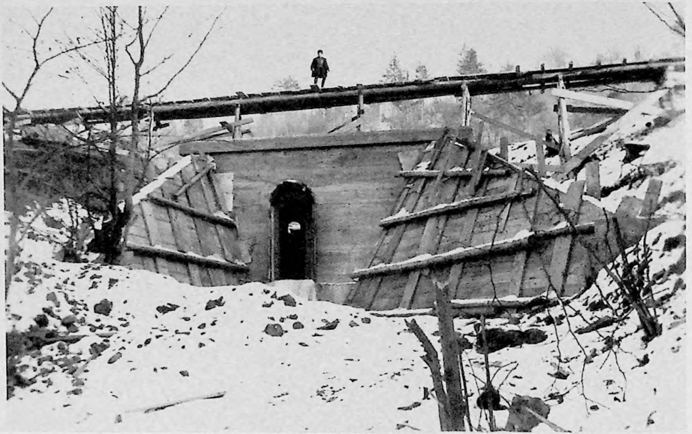
118. Podet - Km 32+465. Vedere aval/ 16 decembrie 1948
