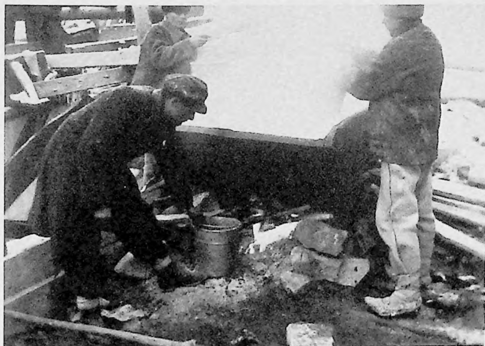
80. Încălzirea apei pentru betonieră, începutul lui noiembrie
