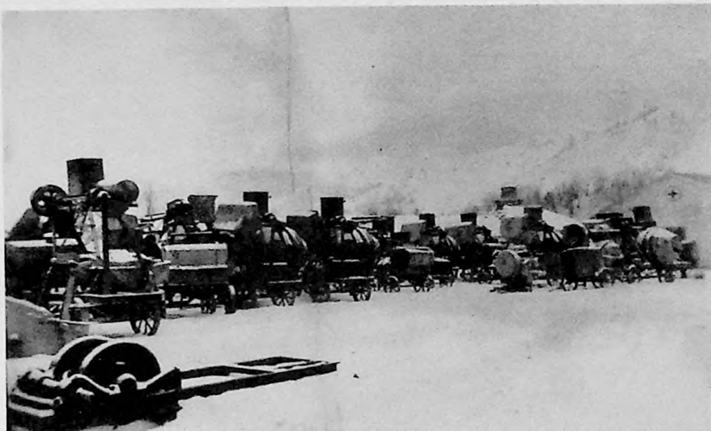
128. Betonierele de la toate loturile adunate la grupul UTM/ 16 decembrie 1948
