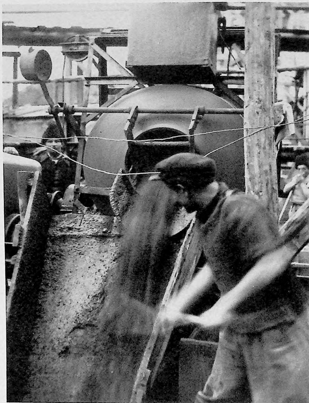
63. Valea Voicului - Pila 4. Betonarea fundației/ 4 noiembrie 1948
