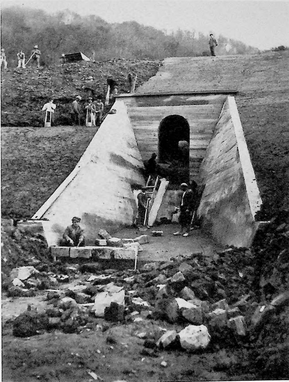
25. Podeț - Km 30 + 936. Vedere aval. Zidăria radierului/ 27 octombrie 1948
