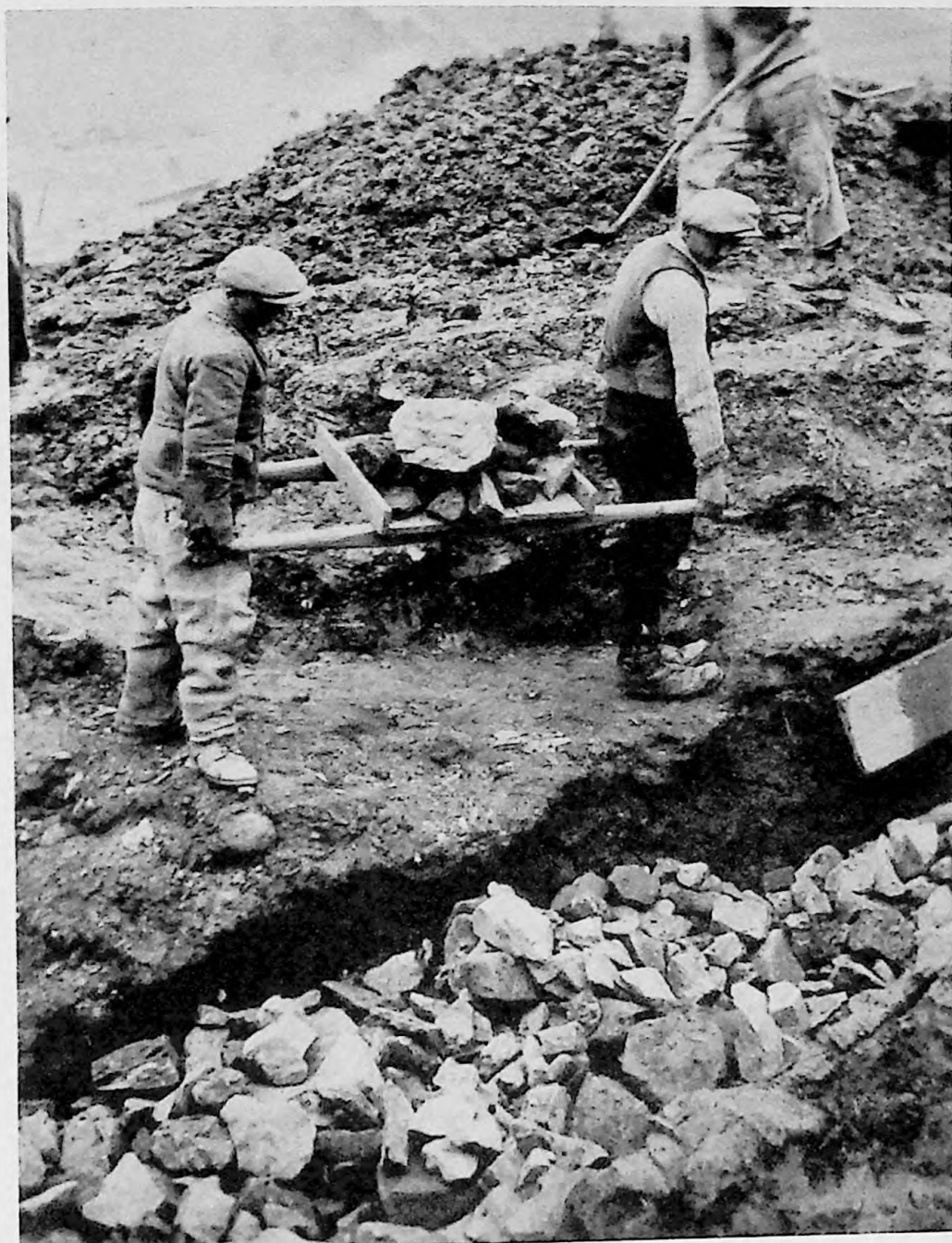
41. Dren - Km 31+619. Umplură cu piatră/ 1 noiembrie 1948
