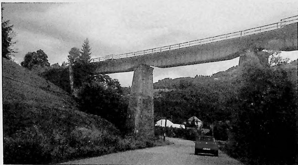
Viaductul de la Romuli/ Romuli Viaduct. 2018. Foto/ Photo: Olga Ștefan
