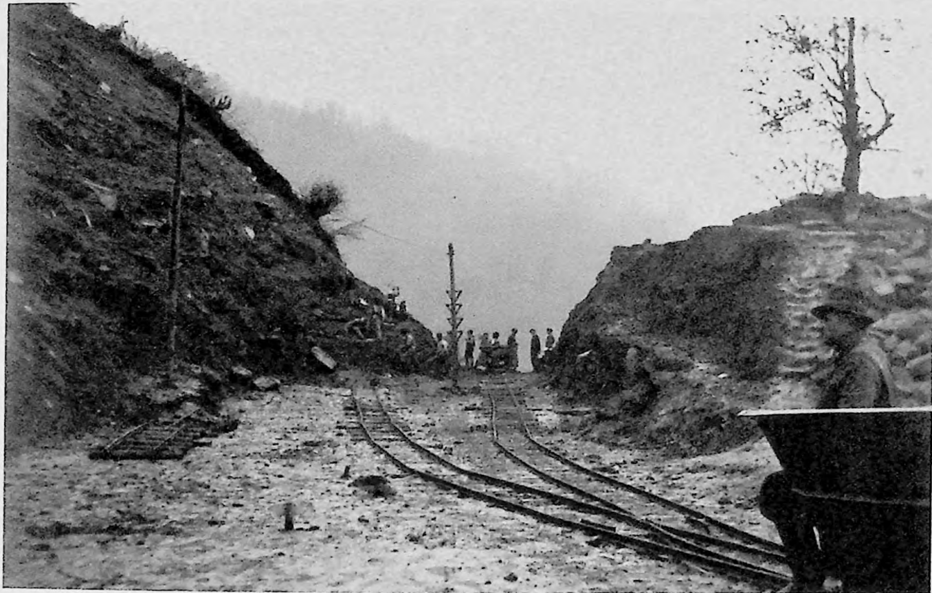
44. Terasamente - Tranșeia km 30+065 - 30+110. Vedere Salva/ 2 noiembrie 1948
