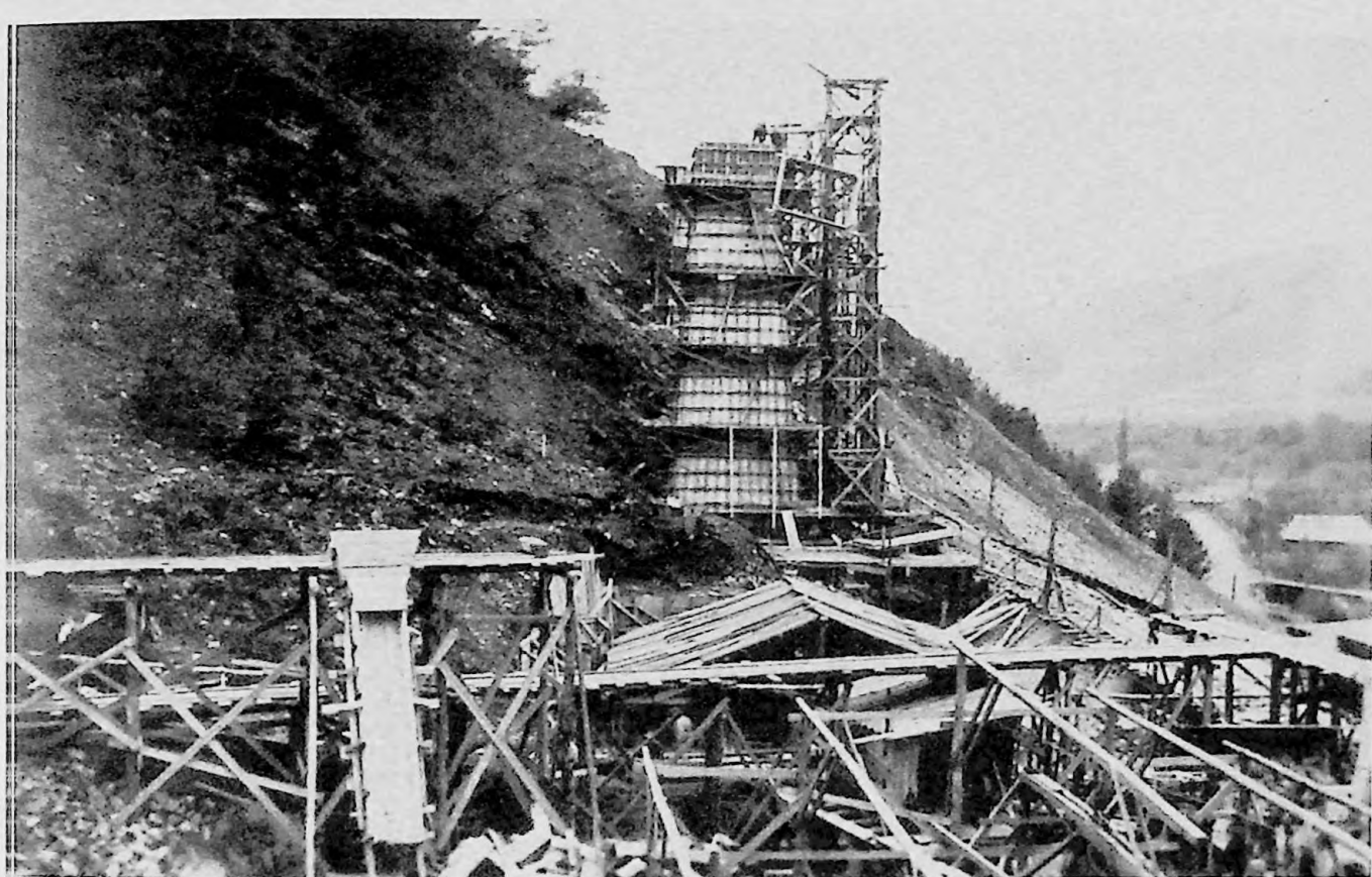
14. Viaductul Valea Voicului - Vedere Vișău. Pila 3. Podurile de serviciu. Cariera - pila 5; cariera - pila 4 etc./ 23 octombrie 1948
