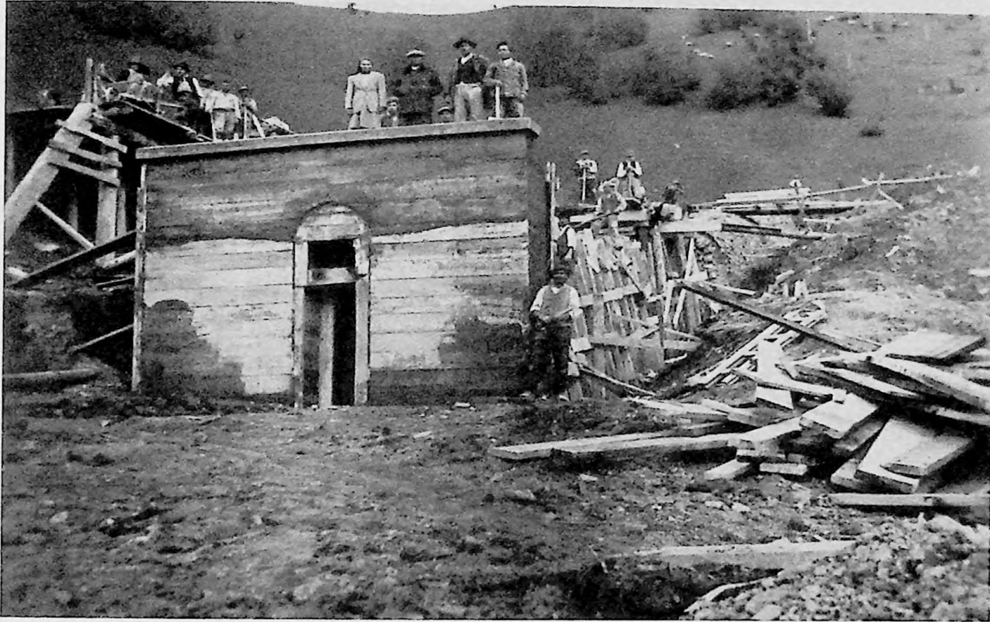
21. Podet - Km 31+625. Vedere aval/ 27 octombrie 1948
