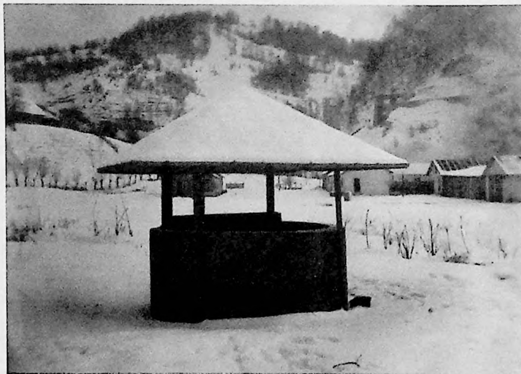
126. Valea Voicului - Puț betonat la tabăra UTM/ 16 decembrie 1948
