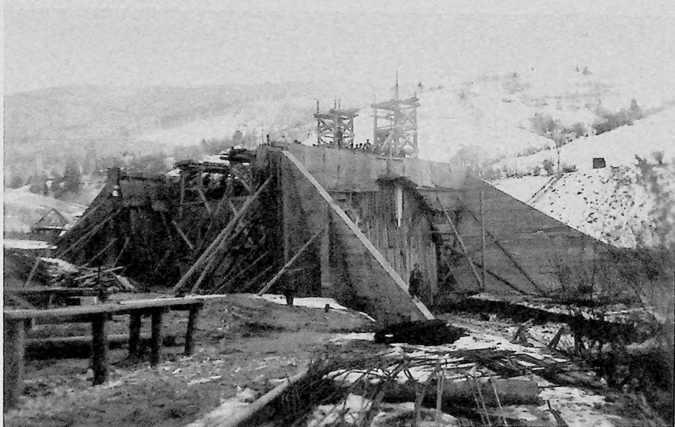
91. Valea Frasinului - Betonarea. Probabil lotul 2. Vedere aval/ 15 decembrie 1948
