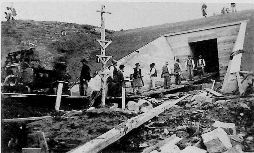
27. Poduț - Km 30+350. Umplutură cu beton pentru radier/ 28 octombrie 1948
