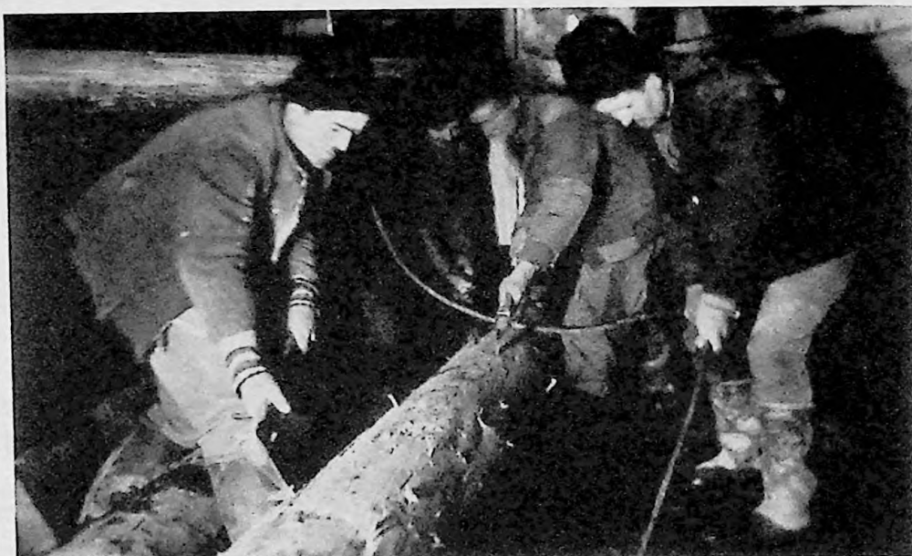
93. Valea Voicului - Pila 8. Betonarea fundației. Scoaterea cadrelor/ 9 decembrie 1948
