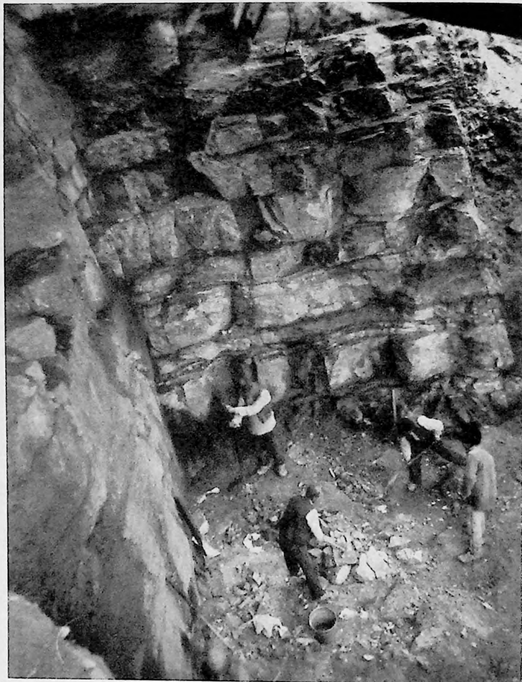
46. Valea Voicului - Săpătură în stâncă pentru fundația culeii Vișău (varianta 2) / 2 noiembrie 1948
