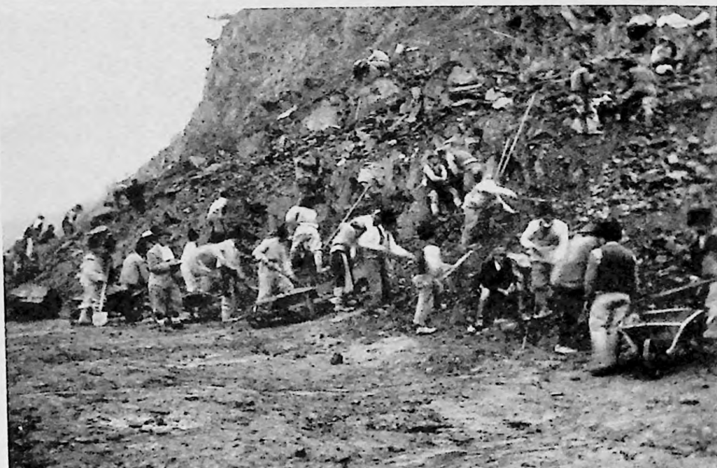
Terasamente debleu în stâncă, km 30+240, 2 noiembrie 1948/ Embankment km 30+240, November 2, 1948. Foto/ Photo: Clement Ștefan
