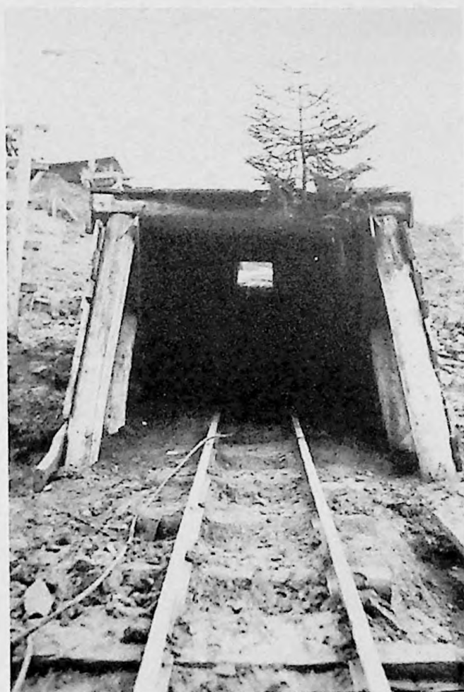
58. Valea Voicului - Planul înclinat 3. Tunel de protecție, în timpul aprovizionării pilei 8/ 4 noiembrie 1948
