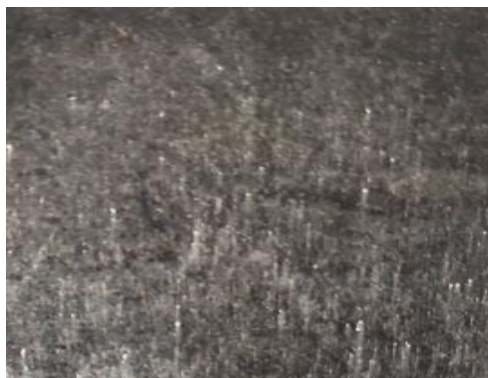
Figura 4.4. Stratul de suprafață al epruvetei S01 după ce aceasta a fost dispusă vertical
