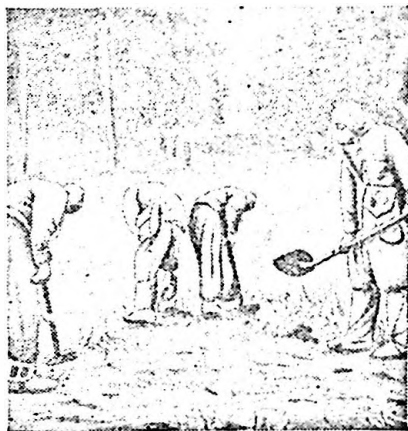
Fig. 114. — Dezactivarea terenului prin îndepărtarea stratului superficial de pământ.
