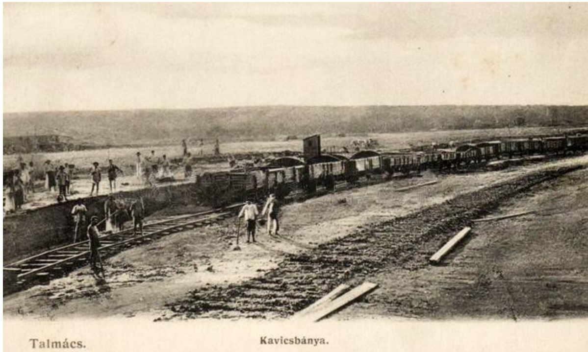
Construirea căii ferate la Tălmăciu, datare 1900
