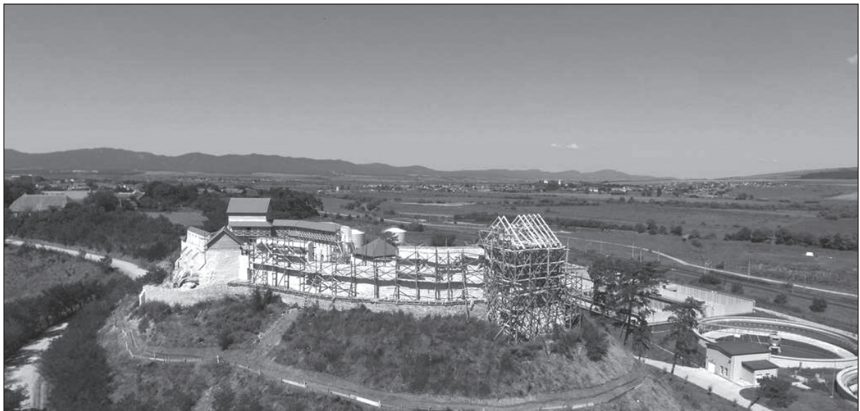
Foto 1. Feldioara - imagine aeriană din timpul lucrărilor de restaurare
