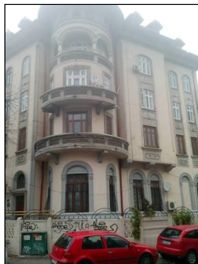
Blocul meu, balconul al doilea
