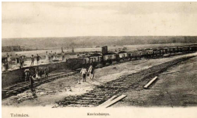
Construirea caii ferate la Talmăciu, 1900
