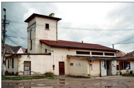
Fig. 470. Făgăraș (jud. Brașov). Remiza de pompieri a Grupului de Pompieri construită în perioada interbelică, primind altă destinație (Foto: 2013)
