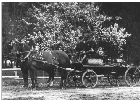
Fig. 469. Ghimbav (jud. Brașov). Motopompă pe benzină de stins incendii montată pe platforma unui car (Fotografie fin jurul anului 1935)
