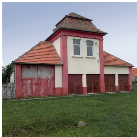
Fig. 534. Grabăț (jud. Timiș). Remiza de pompieri în stare de funcționare (Foto: 2013)
