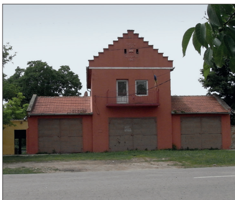
Fig. 528. Bulgăruș (jud. Timiș). Vechea remiză de pompieri în stare de funcționare (Foto: 2012)
