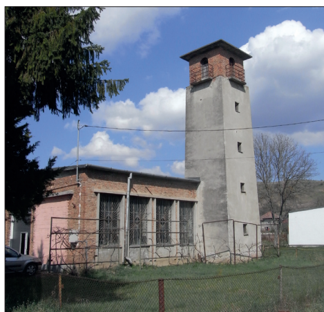
Fig. 497. Fântânele (jud. Mureș). Turnul fostei remize de pompieri aparținând centralei termo-electrice (Foto: 2014)
