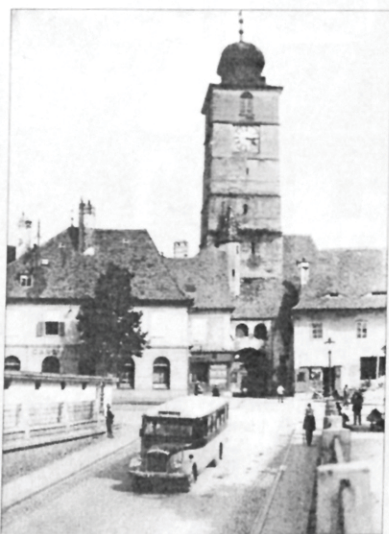
53. Turnul Sfatului și clădirea alăturată, din dreapta, înainte de a fi parțial demolată pentru a se construi pasajul boltit de trecere spre Piața Mare. Fotografie ante 1930.
