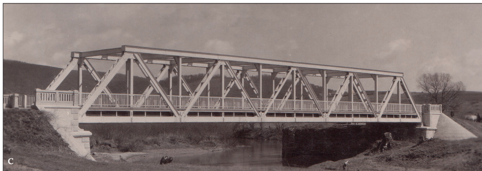
Fig. 209 c. Sighișoara (jud. Mureș). c) Podul metalic construit în locul lui în 1935 – 1936 sub care se văd la capăt urmele unui pilon vechi
