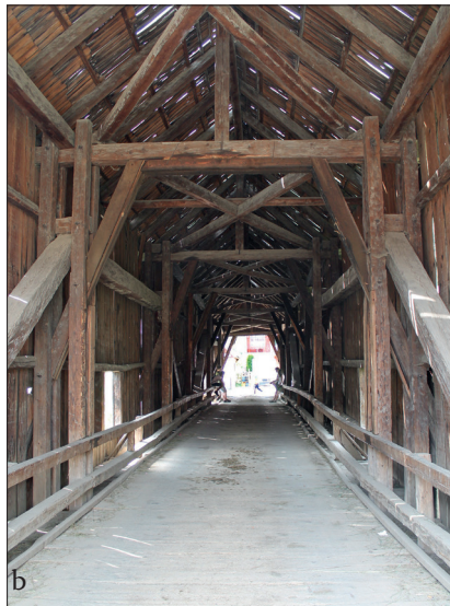
Fig. 214 a - b . Coșbuc (jud. Bistrița-Năsăud). Podul de lemn acoperit peste râul Sălăuța, a) Elevația podului de lemn acoperit, văzut din amonte, b) Grinzile de lemn cu contrafișe și carosabilul podului (Foto: 2013)
