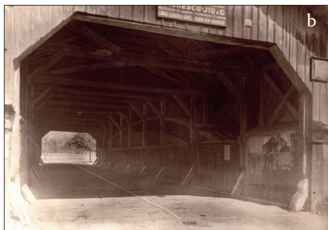
Fig. 210 a - c. Sighișoara (jud. Mureș). Podul de lemn acoperit peste Târnava Mare numit „Mamut” sau „Maria Theresia,” a) Carosabilul podului văzut de pe malul stâng al râului Târnava Mare (Fotografie din jurul anului 1940); b) Grinzile din lemn cu contrafișe și carosabilul podului (Fotografie din jurul anului 1920); c) Podul acoperit parțial de podul de cale ferată îngustă, fotografiat în momentul probei de rezistență cu trei locomotive (Fotografie din anul 1896)
